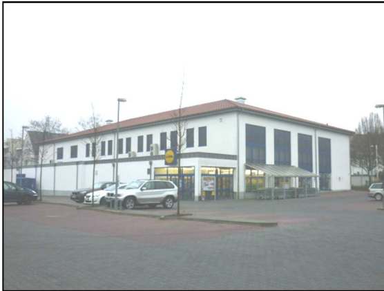
Blick auf die westliche Ecke vom Parkplatz aus
