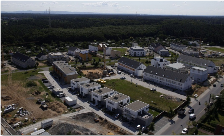
Bild 2: Luftbild Baugebiet „Waldheim-Süd“; südlicher Teil“ im August 2013, Blick Richtung Südosten
