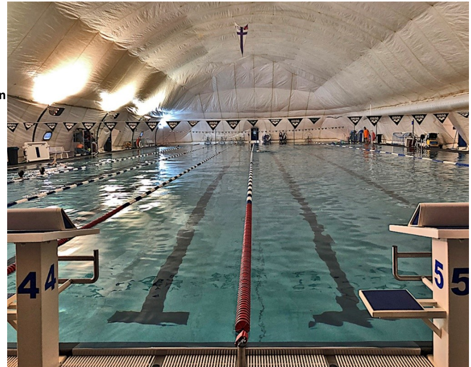
SB-Becken unter Traglufthalle
