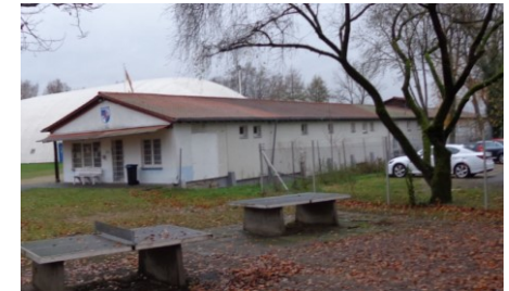
Eingangs-/Umkleidetrakt Quelle: Duzia
