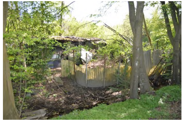
Abbildung 5: Unzulässige Bauten am Röhrgraben
