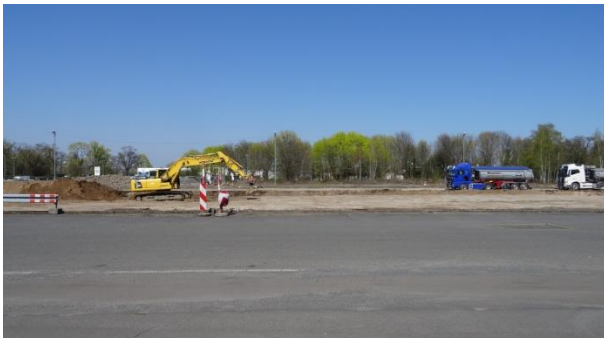
Abbildung 44: Blick auf den nördlichen Gehölzsaum in Richtung Norden am 09.04.2016
