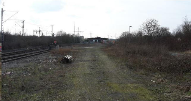
Abbildung 51: Blick entlang der südlichen Gleise Richtung Westen
