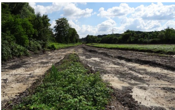
Abbildung 48: Rückgebaute Gleisanlage am 01.08.2016
