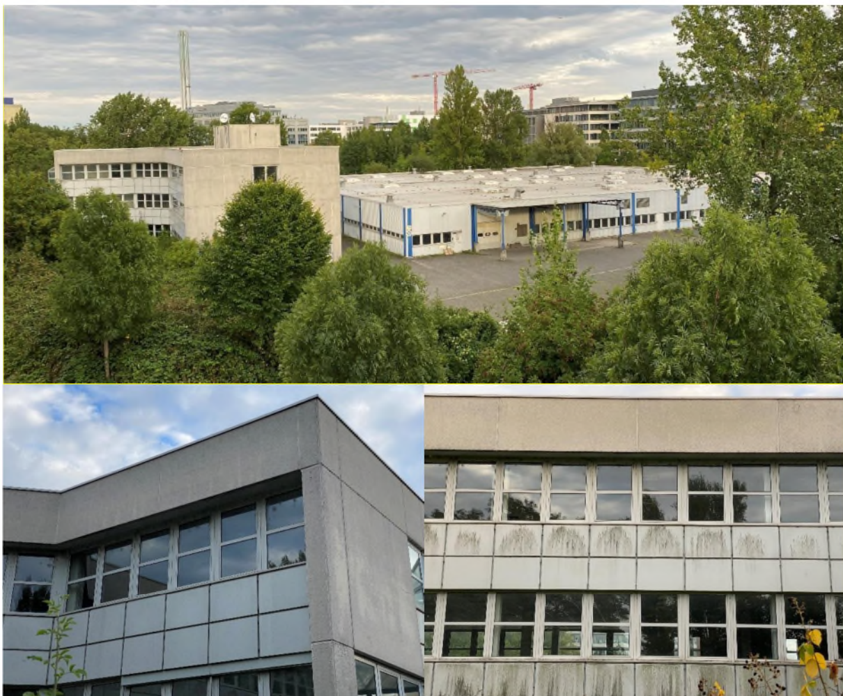
Abbildung 3: Das westliche Bürogebäude mit großer Lagerhalle (Nordring 150). Das Bürogebäude ist schon lange verlassen.
