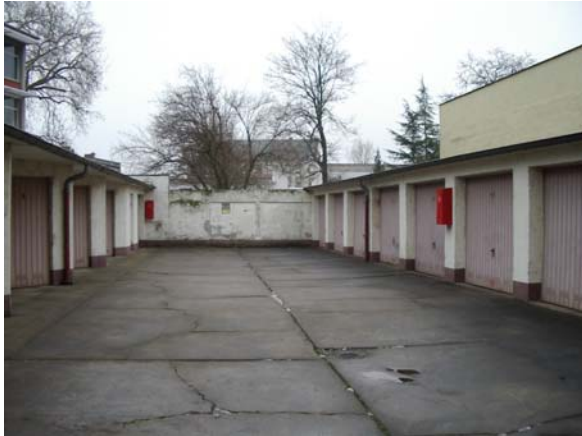
Garagenhof Bieberer Straße
