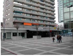
Abb. 67: Wohnen in den OG's des "Signal-Iduna-Hauses"
