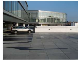
Abb. 33: Parken auf dem Dach des KOMM
