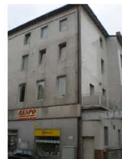
Abb. 28: Sanierungsbedürftiges Gebäude in der Waldstraße
