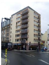
Abb. 13 Sanierungsbedürftiges Wohnhaus, Kaiserstraße / Geleitsstraße
