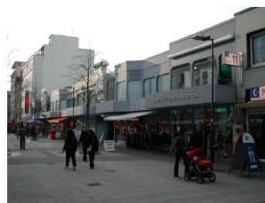
Abb. 39: Teil-Leerstände in der City-Passage Frankfurter Straße
