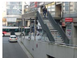
Abb. 10 Gestörte Gebäudeerschließungen als Folge des Rückbaus der 2. Ebene
