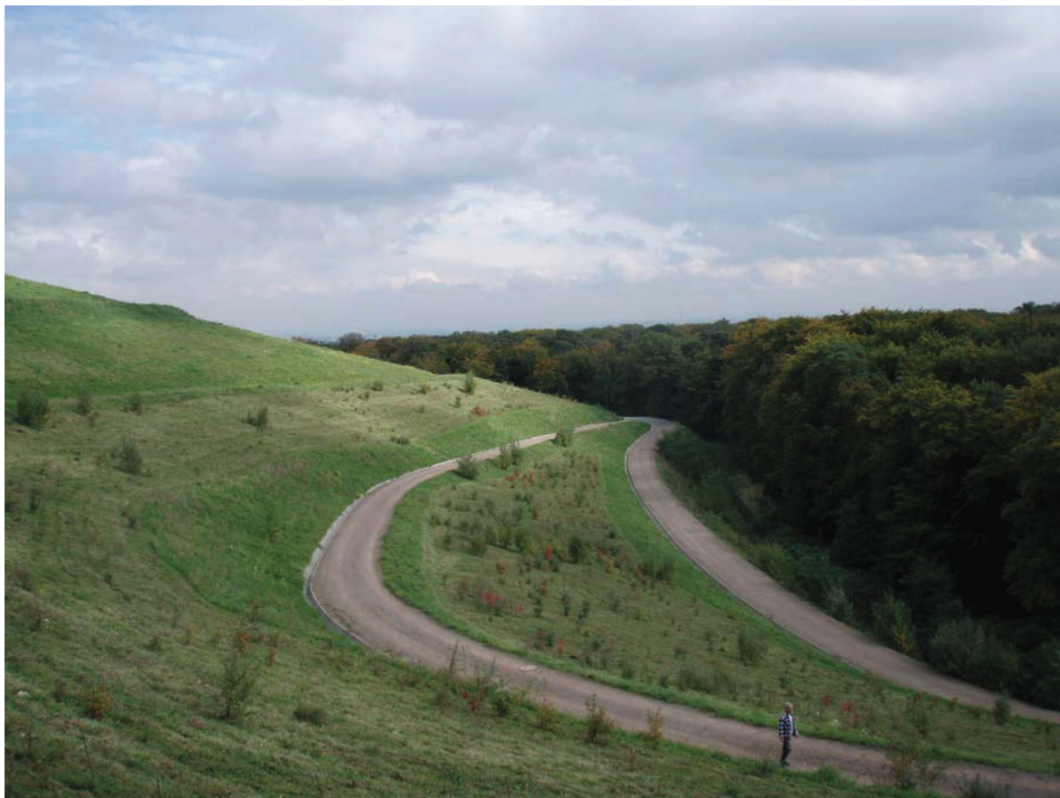
Abbildung 3-1 Blick von der Südostflanke des Deponiekörpers (ca. mittlere Böschungshöhe) in Richtung Osten (Foto: Planungsbüro Bierschenk)
