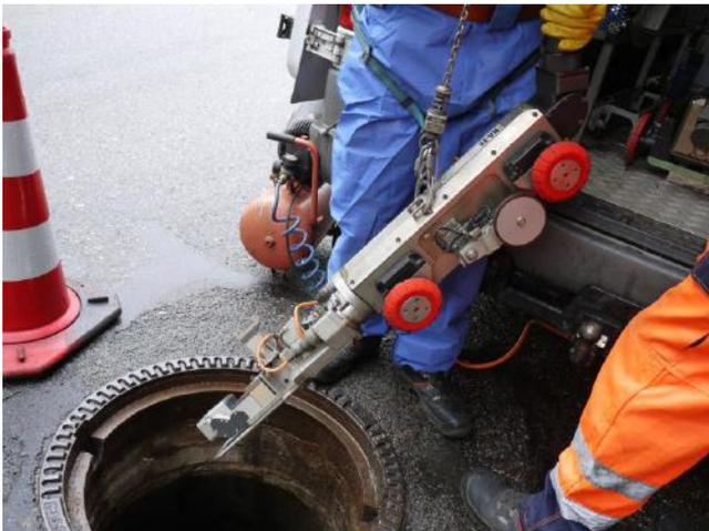
**Abbildung 45: Roboter zur Verlegung des Leerrohrsystems am Schachteingang, Quelle: seim & partner/ Netzbau Sasbachwalden**
