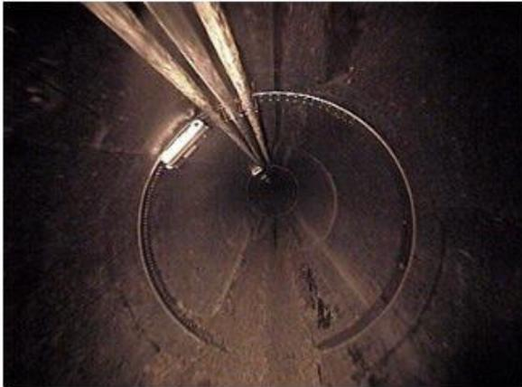
**Abbildung 44: Spannring mit Edelstahlrohren in Abwasserkanal, Quelle: fastopticom.de**
