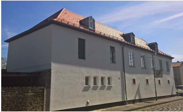
Positives Beispiel für Fassadengliederungen einer Bestandserweiterung in Rumpenheim
