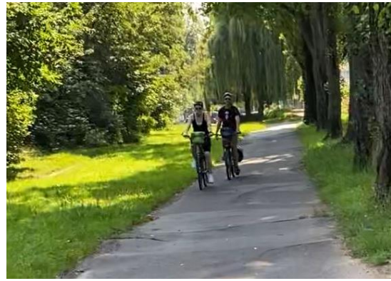
Bild 4: Bsp. Beseitigung von Wurzelschäden
