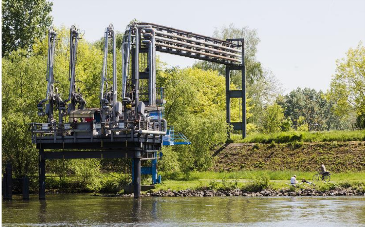
Bild 10: Rohrbrücke; © Jessica Schäfer
