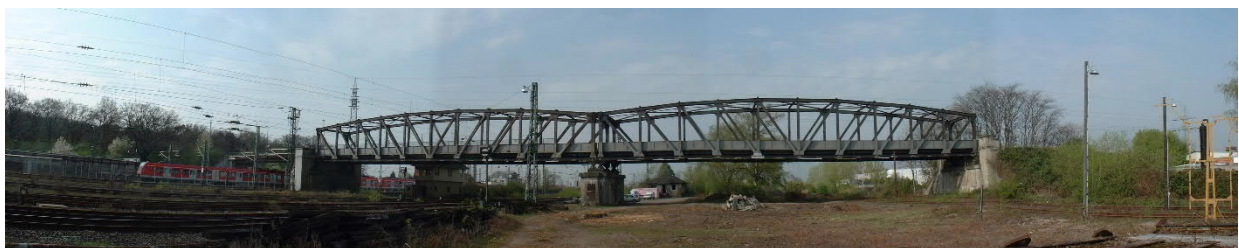
Abbildung 2: Ansicht der Brücke von Westen
