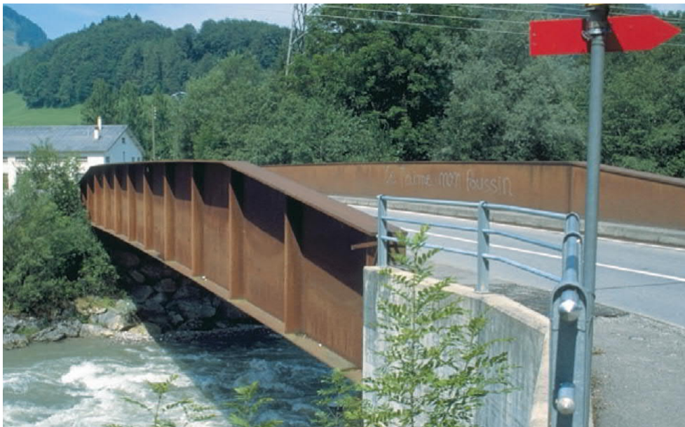
Abbildung 18: Brücke in der Schweiz aus wetterfestem Stahl, Quelle: www.peterknoedel.de
