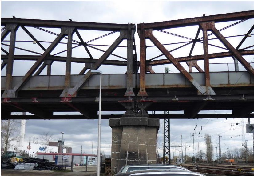
Abbildung 4: Bauwerkszustand im März 2018
