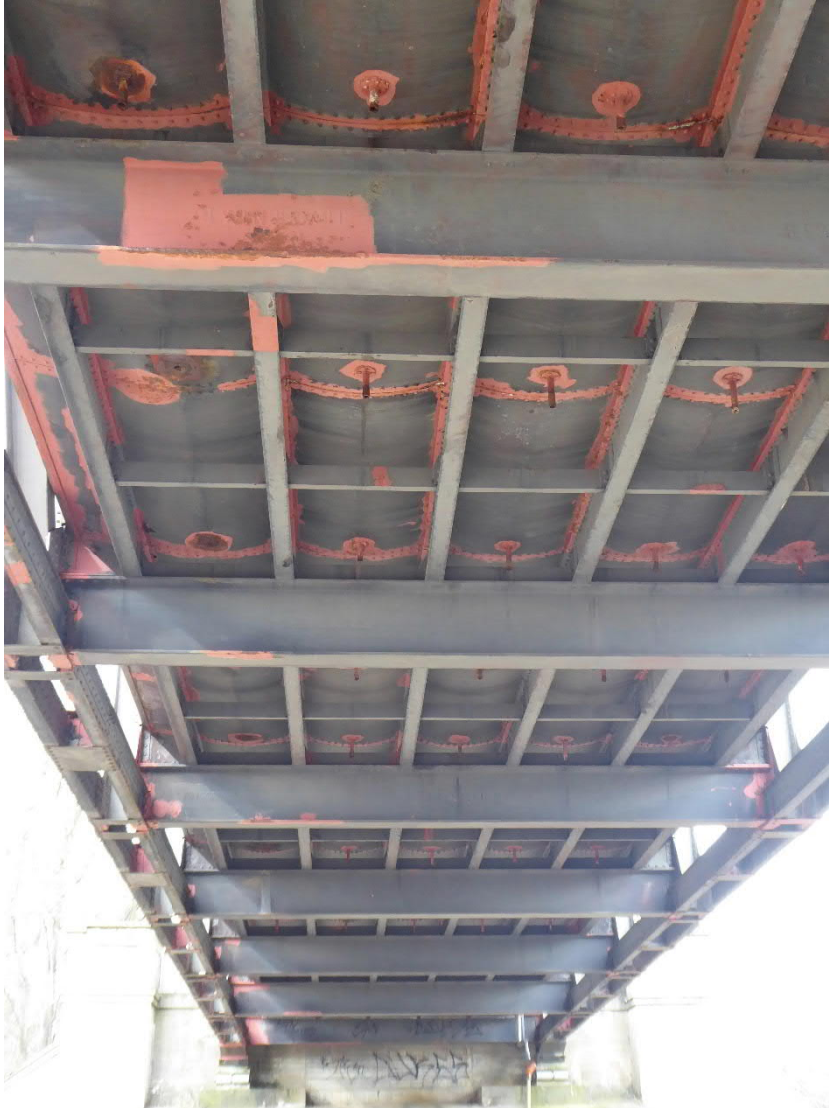
Abbildung 10: Ansicht der Brücke von unten
