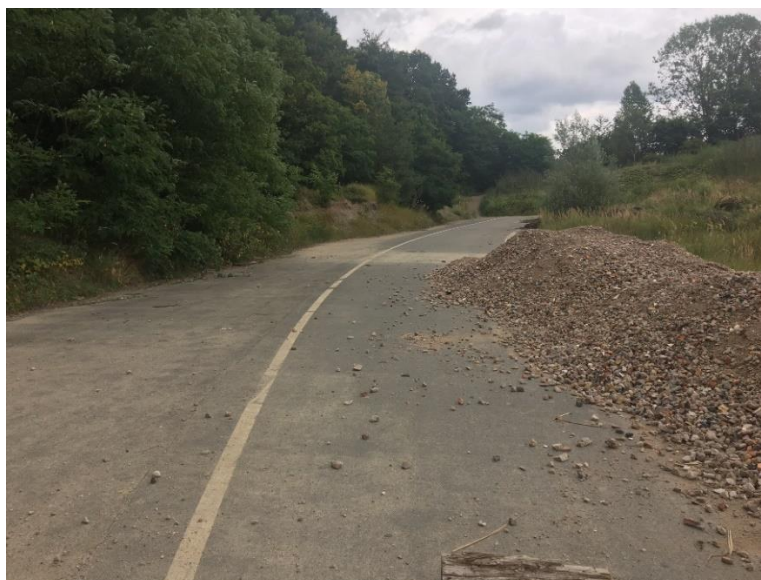
Foto 11 Asphaltflächen am Ohr im Bereich der Motorcrossstrecke. Diese sollen für die Zauneidechsen entsiegelt und als Ersatzhabitat aufgewertet werden.
