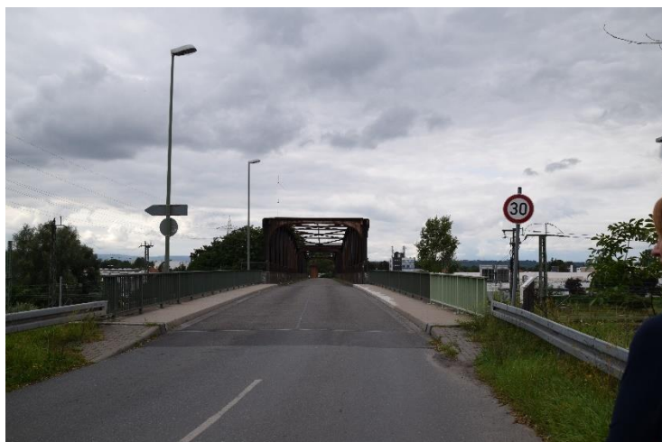
Foto 1 Blick auf die Bestandsbrücke über die Gleise im Norden des UG 500 . Sie soll an gleicher Stelle ersetzt werden.
