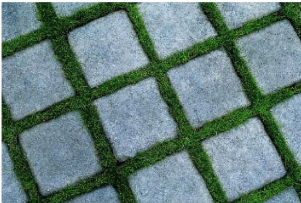
Abbildung 3: Beispiel wasserdurchlässige Befestigung, Rasenfugenpflaster (eigene Darstellung)
