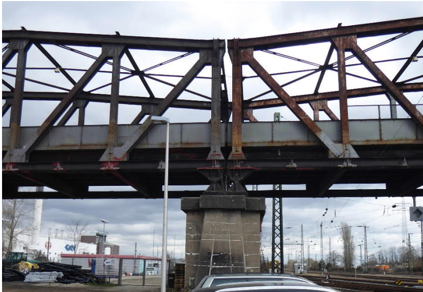
Abbildung 4: Bauwerkszustand im März 2018
