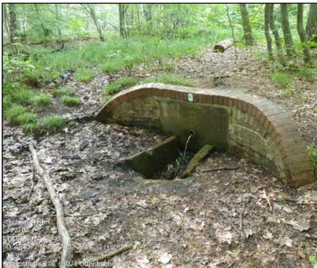
Abbildung 26: Quellfassung "Schäferborn" mit Einlaufbauwerk, Foto: techverm GbR, 24.03.2022
