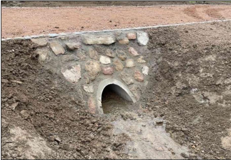
Abbildung 32: Planung – Rohrdurchlass mit Substratsohle, Foto: Francke + Knittel GmbH
