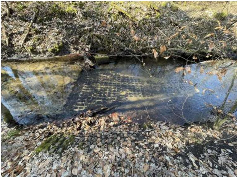
Abbildung 29: Rückzubauende Sohlschwelle aus Gitterplatten, Foto: techverm GbR, 24.05.2022
