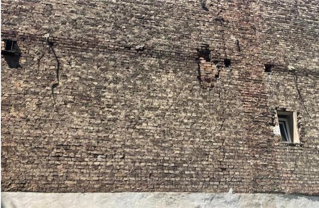
Abbildung 2: herausragende Stahlträger und Eisenbänder, Hohlstellen, Risse und eine Fensteröffnung in Brandwand, Geleitsstraße 44 (Wellnitz)
