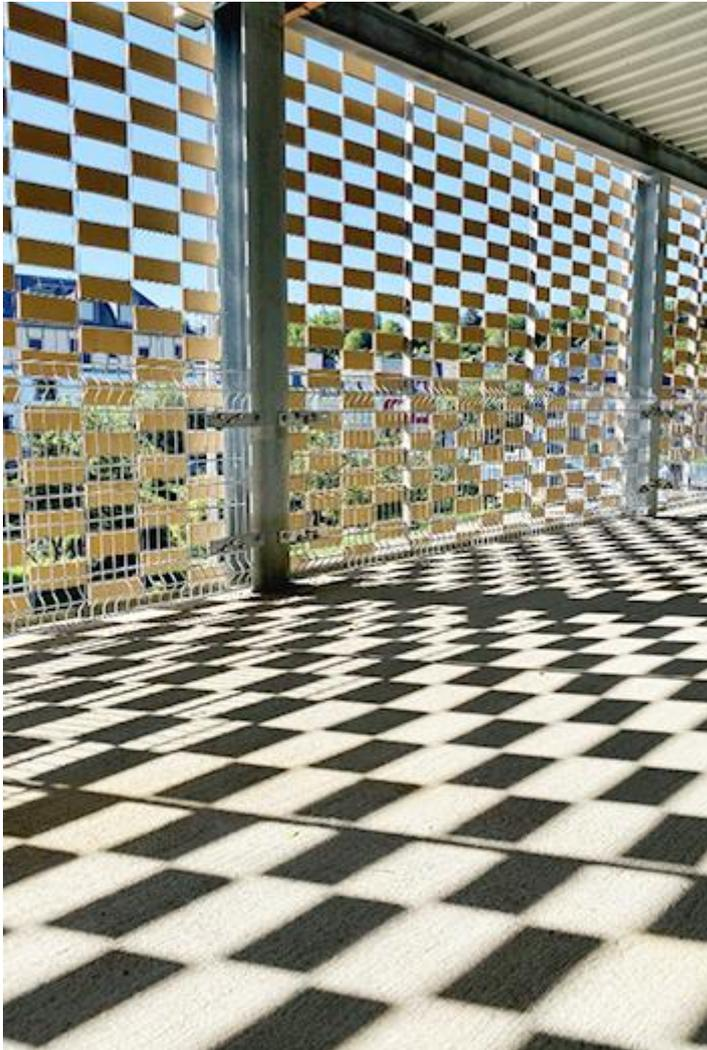
Abbildung 26: Keramikgewebe als Fassade am Beispiel Parkhaus Ettelbrück, Luxemburg (Quelle: <https://www.astron.biz/de/unternehmen/news/detail/keramikgewebe-als-fassade/>)
