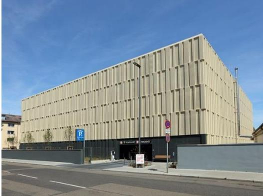
Abbildung 22: Beispiel perforierte Metallprofile (Quelle: dfgb.de Parkhaus Hanau)
