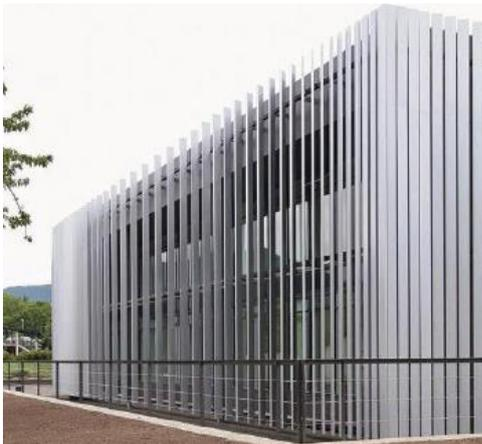
Abbildung 21: Beispiel vertikaler Aluminiumlamellen (Wellnitz)
