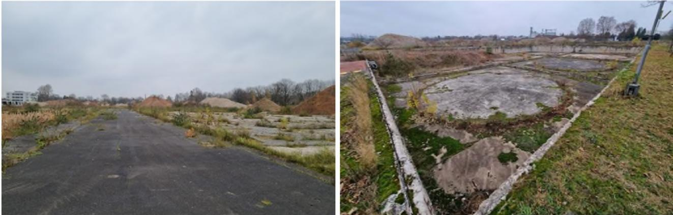
Abbildung 15: Restliche Halden und Fundamente der Abrissmaßnahmen (Quelle: Eigene Aufnahmen Planergruppe ROB GmbH, Schwalbach am Taunus)
