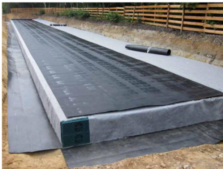
Abbildung 23: Unterirdische Zisterne zur RW-Nutzung (Beispiel RigoCollect, Fränkische)
