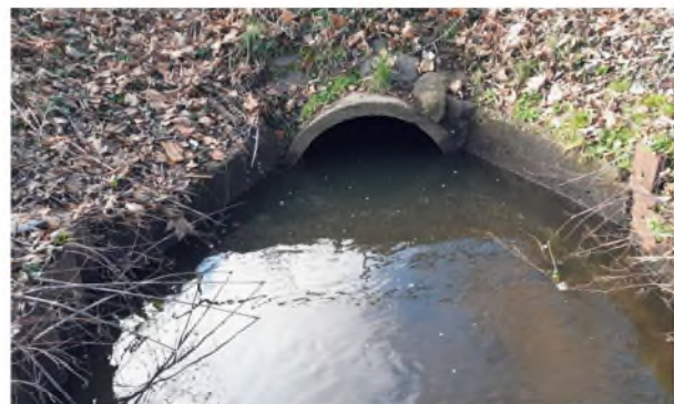
Abbildung 9 Senkrechte Uferverbauung (links), Verrohrung (rechts) (© 2023 CDM Smith)
