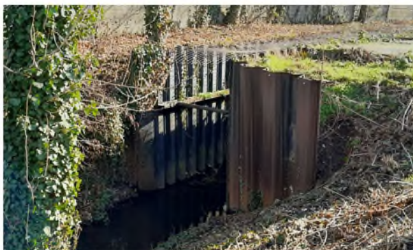
Abbildung 9 Senkrechte Uferverbauung (links), Verrohrung (rechts) (© 2023 CDM Smith)
