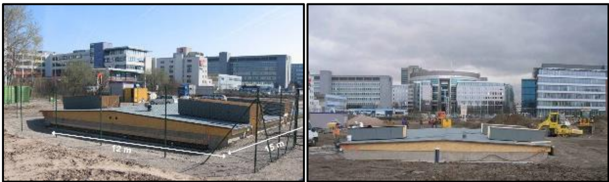
Abbildung 31: Ansicht des Gate-Bauwerks während der Bauphase [aus [11]]
