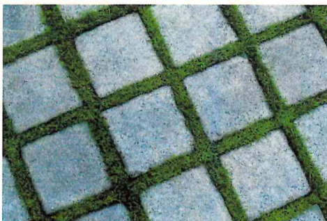
Abbildung 1: Beispiel wasserdurchlässige Befestigung, Rasenfugenpflaster (eigene Darstellung)
