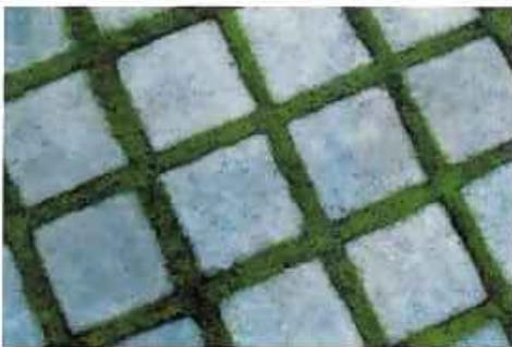
**Abbildung 1:** Beispiel wasserdurchlässige Befestigung, Rasenfugenpflaster (eigene Darstellung)
