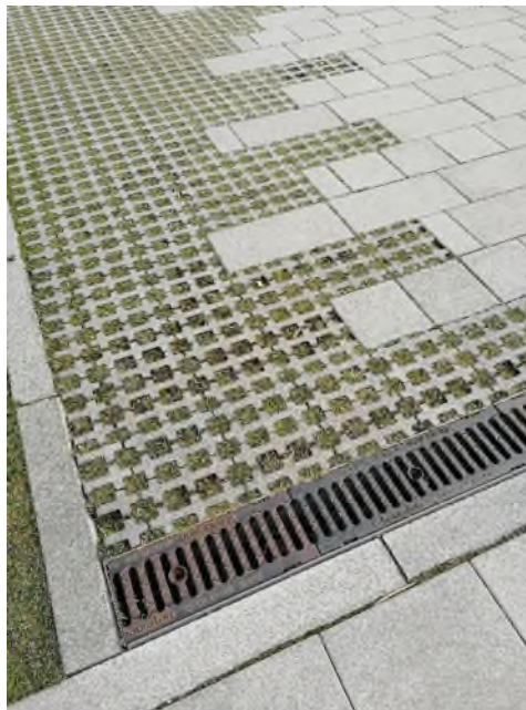
Abbildung 8: Beispiel wasserdurchlässige Befestigung (eigene Darstellung)
