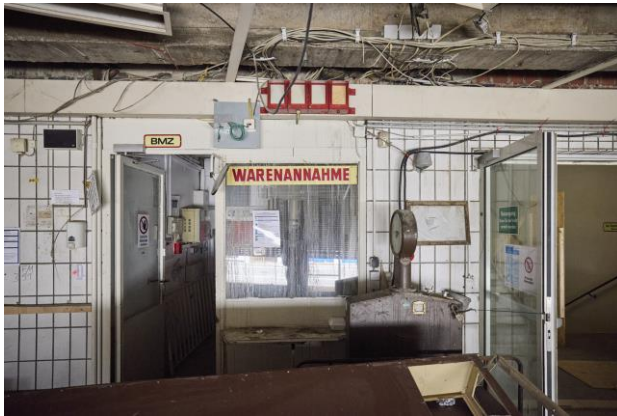
Station Mitte, Letzte sichtbare Reste des Galeria-Kaufhof: „Warenannahme“ im Andienungshof, September 2025
