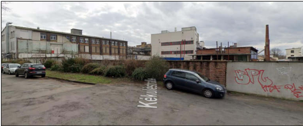
Abbildung 8: Blick auf das Untersuchungsgebiet von Osten (Quelle: Google Streetview)
