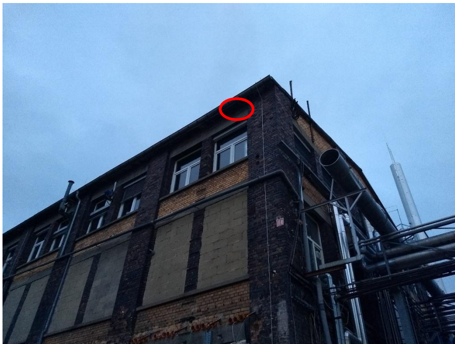
Foto 50: Rot umrandet das Tagesquartier vermutlich der Zwergfledermaus an Gebäude .
