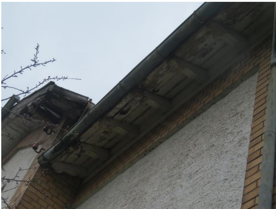
Foto 13: Weitere relevante Strukturen im Bereich des Dachüberstands an der südlichen Seite.
