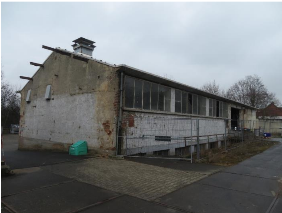
Foto 26: Bei Gebäude Nr.14 handelt es sich um eine alte Lagerhalle mit Stahlträgergerüst. Diese ist offen einfliegbar. Es wurden jedoch weder innen noch außen Hinweise auf einen ehemaligen Besatz vorgefunden.
