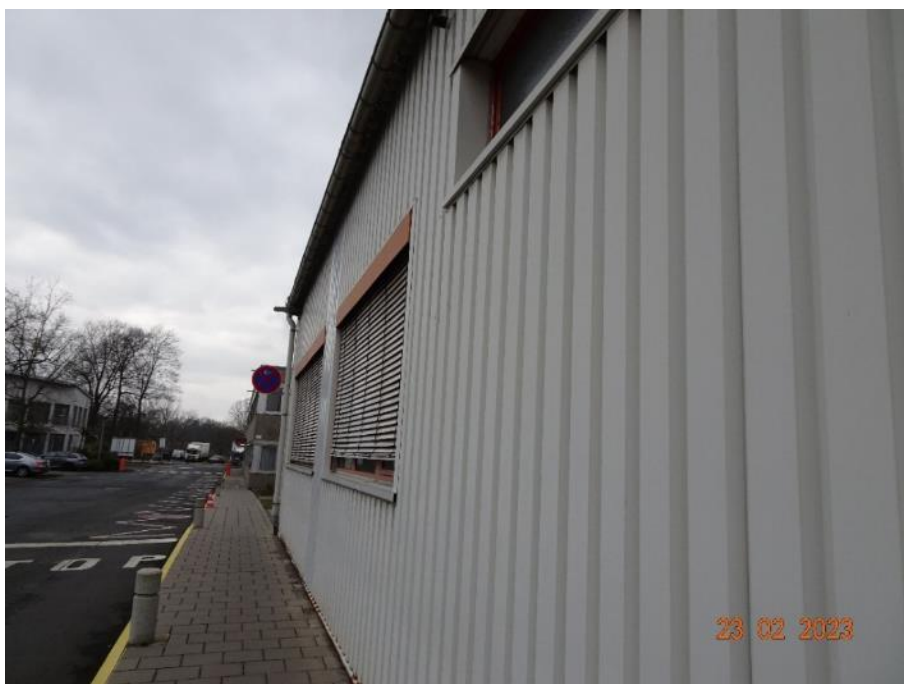
Foto 40: Das ebenfalls mit Blech verkleidete Gebäude Nr. 27 weist nur ein geringes Potenzial auf.
