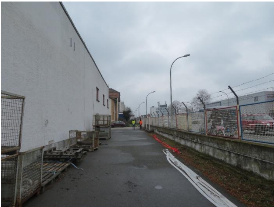
Foto 9: Links im Bild das Gebäude Nr. 24. Dem Gebäude kommt unterhalb der abstehenden und zum Teil beschädigten Attikaverkleidung Quartierpotenzial für Fledermäuse zu.
