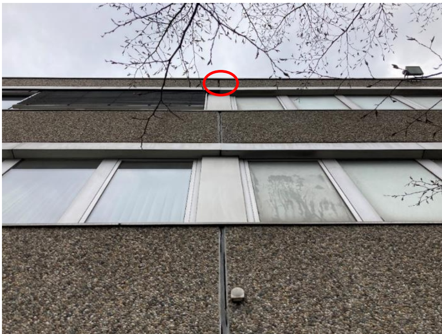
Foto 49: Rot umrandet das Tagesquartier vermutlich der Zwergfledermaus an Gebäude 45.
