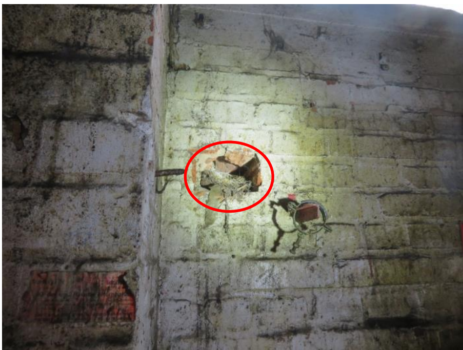
Foto 29: Das Gebäude ist jedoch einfliegbar. Innerhalb des Gebäudes Nr.11 wurden in Nischen insgesamt vier Nester vorgefunden, welche sich anhand der Struktur aller Wahrscheinlichkeit nach auf den Hausrotschwanz zurückführen lassen.
