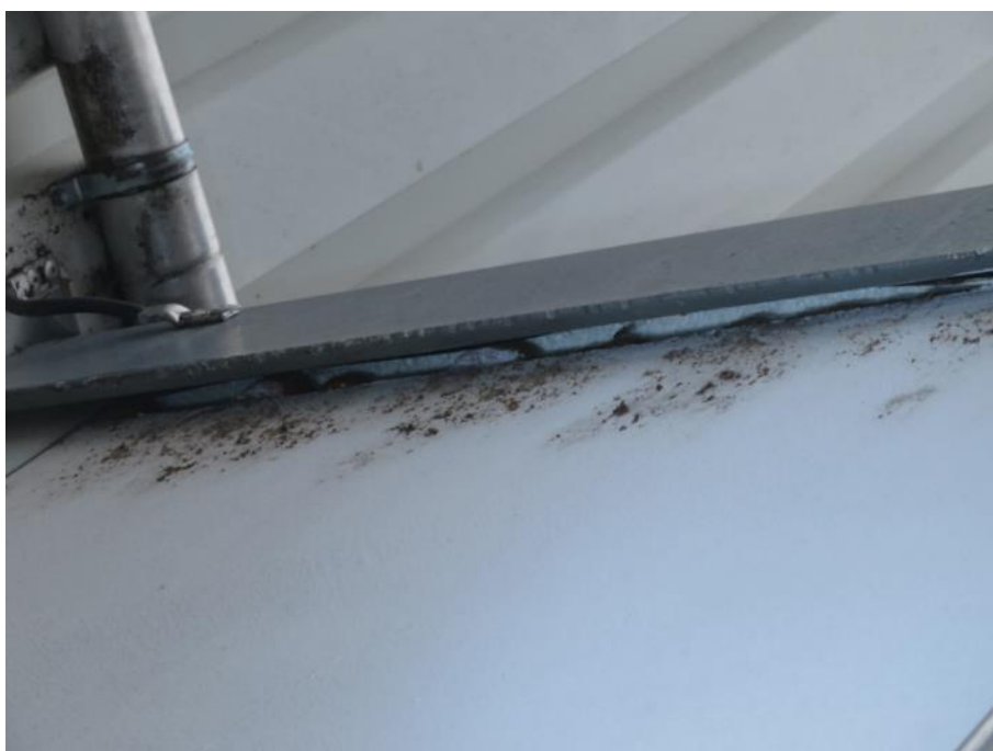
Foto 8: Blick unter die Attikaverkleidung an Gebäude Nr. 43/2 als potenzielles Spaltenquartier.
