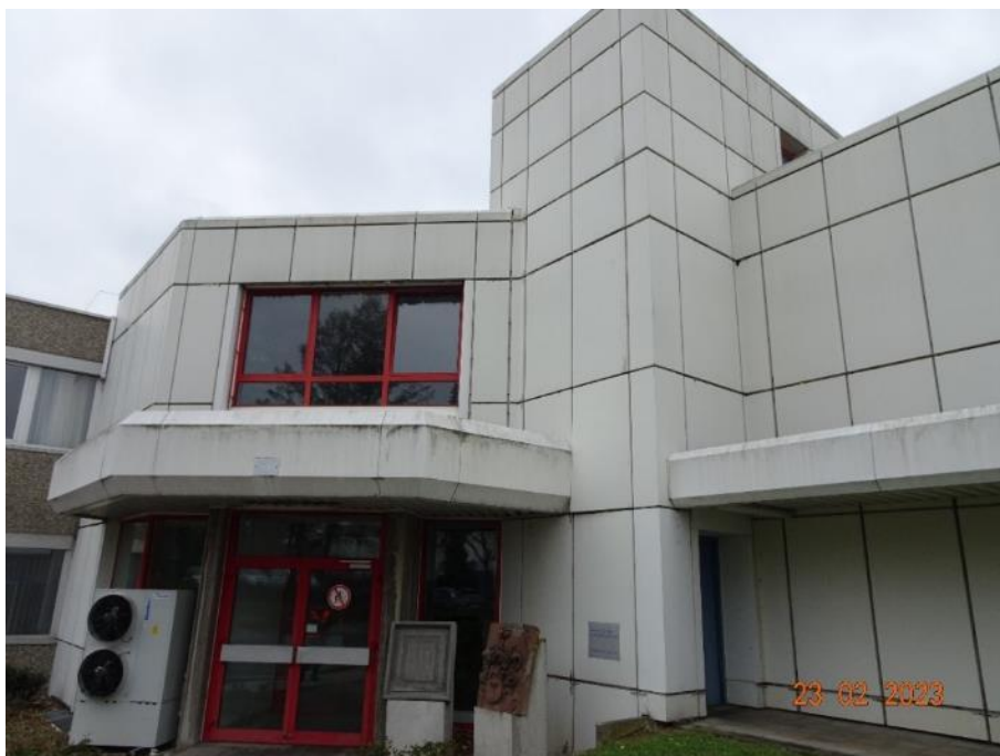
Foto 39: Dem Blech verkleideten Gebäude Nr. 50 kommt insgesamt ein nur geringes Potenzial zu. In den Spalten zwischen den einzelnen Bleckplatten tritt jedoch teilweise Dämmwolle aus, sodass sich ggf. ausreichend große Hohlräume als potenzielle Quartiere bieten.
