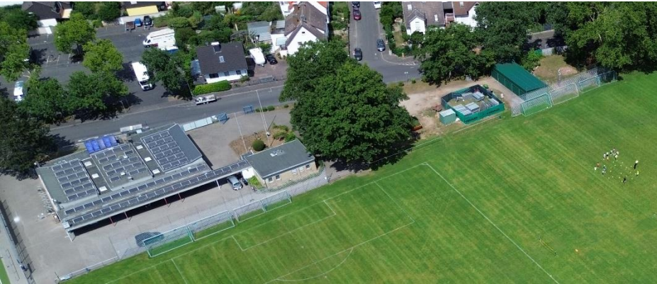
Das Umkleidegebäude entspricht nicht dem aktuellen Energiestandard
