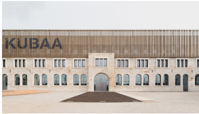
Kulturbahnhof, Aalen Fertigstellung: 2020
