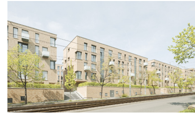
Rosensteinquartie, Stuttgart Fertigstellung: 2018
