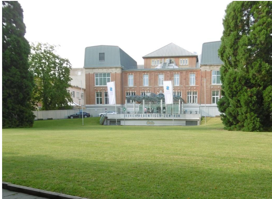
Foto 3: Fassade des ERZ südlich des Anlagenrings
