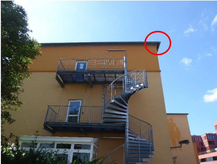
Abbildung 4: An diesem Gebäude wurden zwei Quartiere der Zwergfledermaus registriert (eine Einflugöffnung ist rot markiert).
